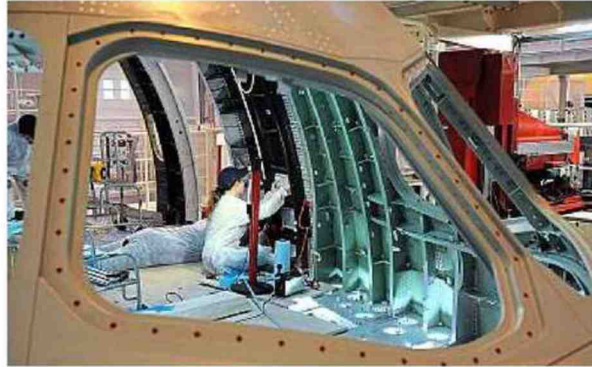
Une intervention est en cours sur la chaîne d'assemblage d'un A350. S. Salam Bamis - Sipa
